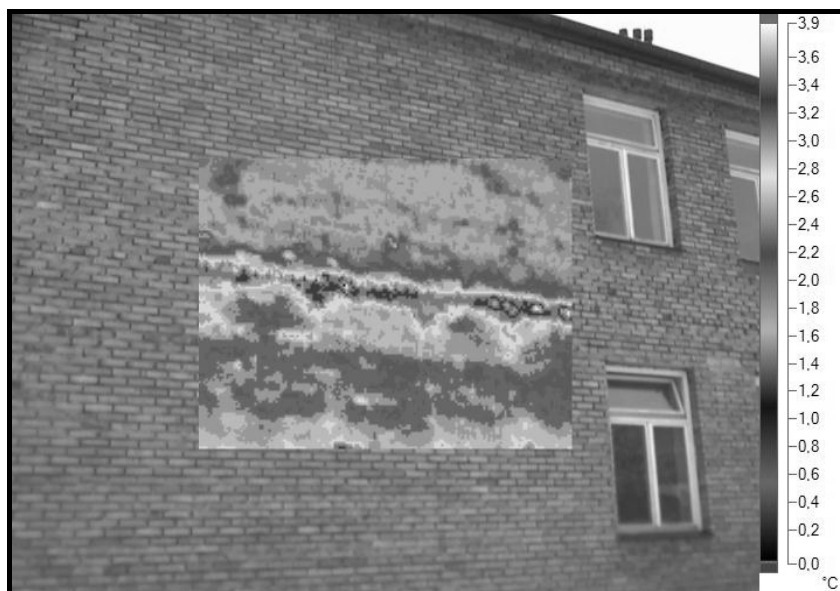
Rys.10. Zdjęcie Szkoły Podstawowej w Buczu (część nowa z zewnątrz), wykonane kamerą termowizyjną przez p. mgr inż. Macieja Surówkę.
