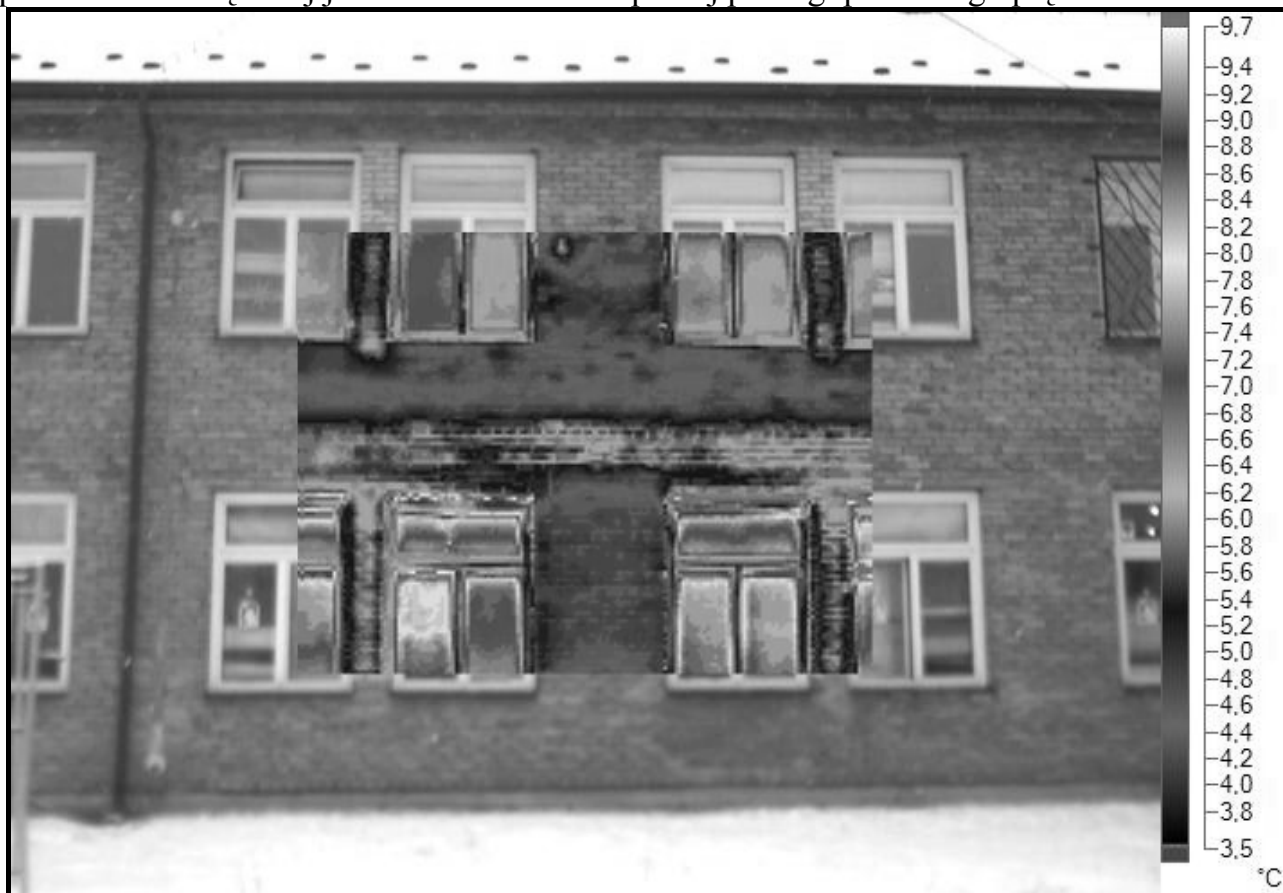
Rys. 7. Zdjęcie Szkoły Podstawowej w Buczu (część nowa z zewnątrz), wykonane kamerą termowizyjną przez p. mgr inż. Macieja Surówkę.
