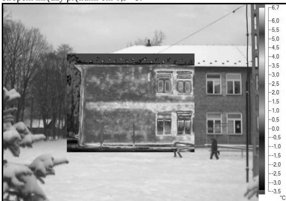
Rys.11. Zdjęcie Szkoły Podstawowej w Buczu (część nowa z zewnątrz), wykonane kamerą termowizyjną przez p. mgr inż. Macieja Surówkę.
