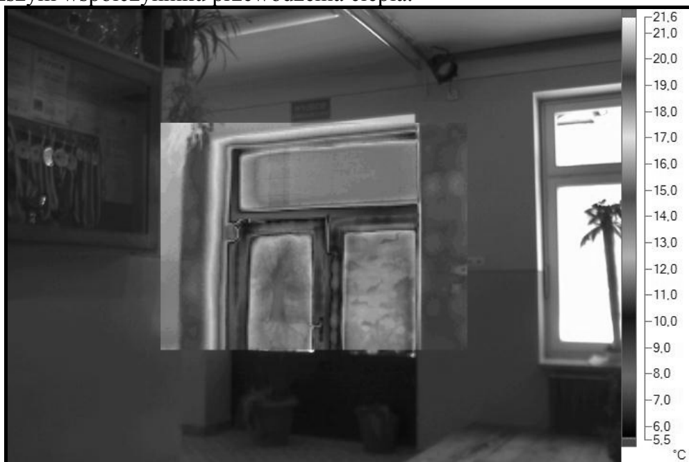
Rys.12. Zdjęcie Szkoły Podstawowej w Buczu (wejście główne od wewnątrz), wykonane kamerą termowizyjną przez p. mgr inż. Macieja Surówkę.
