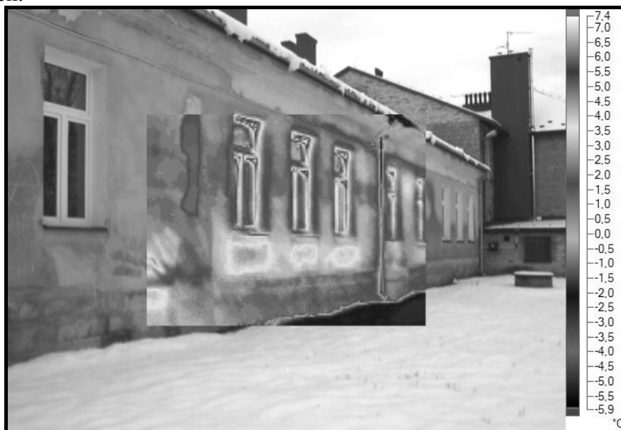
Rys.9. Zdjęcie Szkoły Podstawowej w Buczu (część nowa z zewnątrz), wykonane kamerą termowizyjną przez p. mgr inż. Macieja Surówkę.
