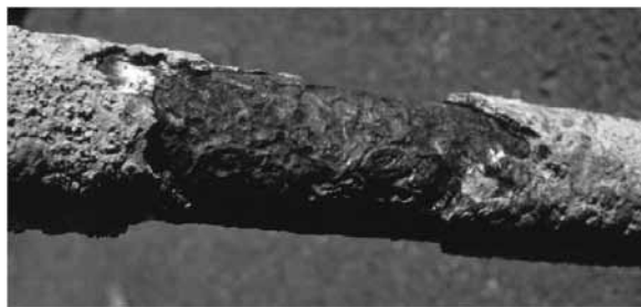
Rys. 7. Korozja rury przegrzewacza po dwóch latach spalania paliw z dużą zawartością chloru [11]
