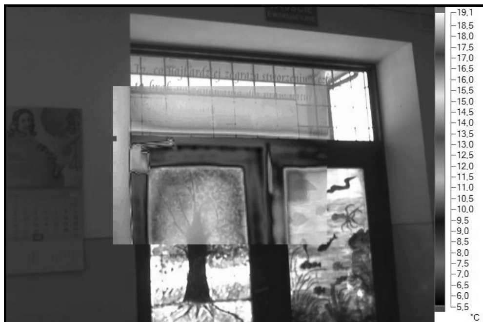
Rys.13. Zdjęcie Szkoły Podstawowej w Buczu (drzwi zewnętrzne metalowe od wewnątrz), wykonane kamerą termowizyjną przez p. mgr inż. Macieja Surówkę.
